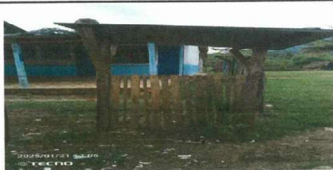
Foto 2: Sustitucion de portón de madera por metal
