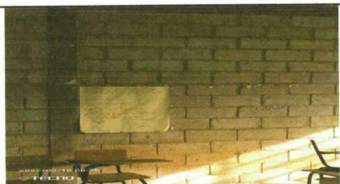
Foto 5: Pintura de interior y exterior.
