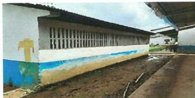
Foto 4: Parte trasera del aula de cuarto primaria que requiere cambio de balcones de madera por balcones de hierro, de igual manera se necesita pintura interior y exterior.
