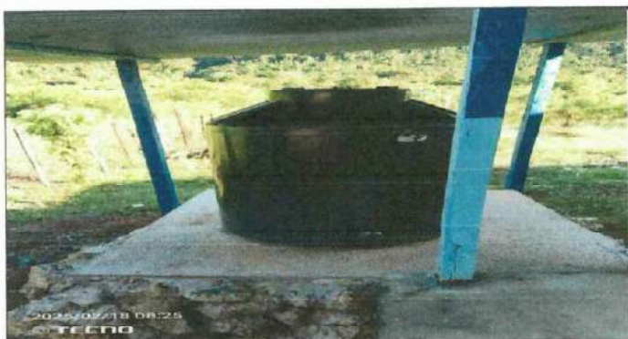
Foto 4: Instalacion de deposito de agua.
