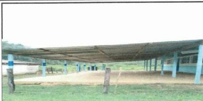
Foto1: Sustitucion de laminas por troquelada y vigas de madera por metal
