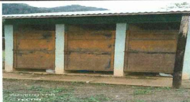
Foto 3: mantenimientos de láminas y puertas.
