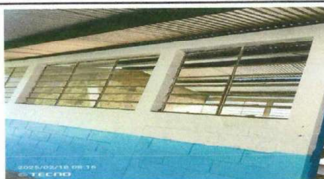
Foto 6: Instalacion de balcones.
